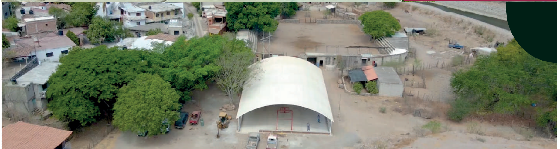
Construcción de domo para la cancha de usos múltiples en "Zacatongo"
