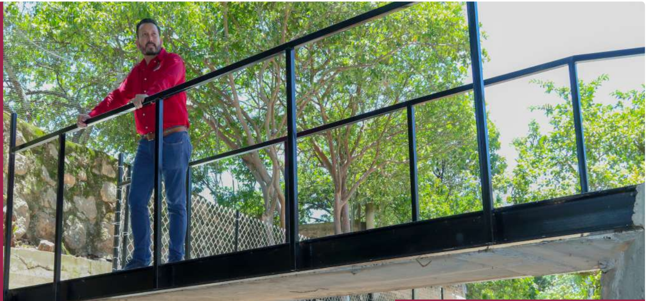
Construcción puente peatonal en "Cimarrón Chico"
