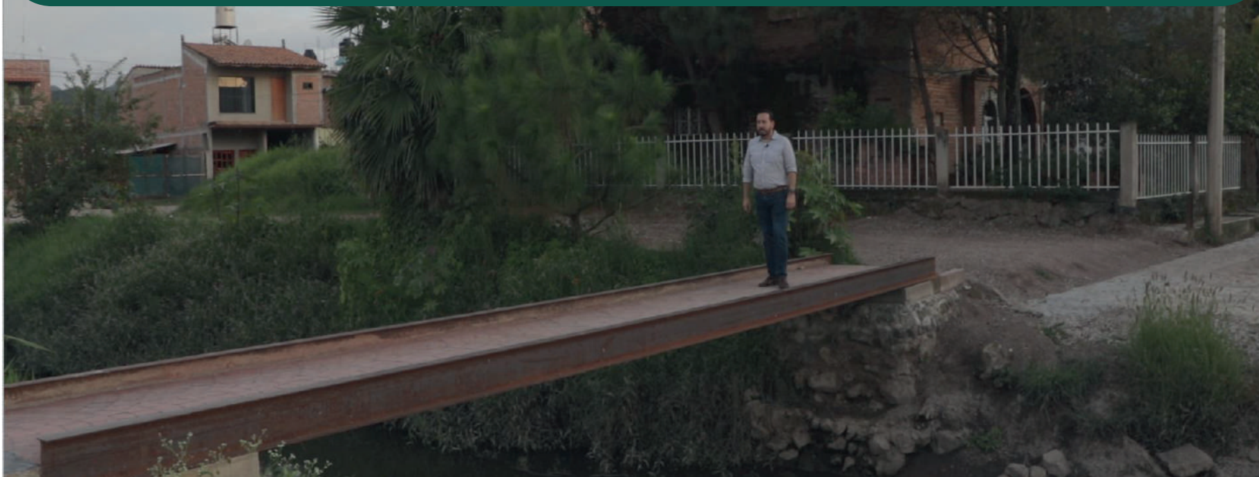
Construcción puente peatonal “Col. La Campiña – Col. Doctores”
