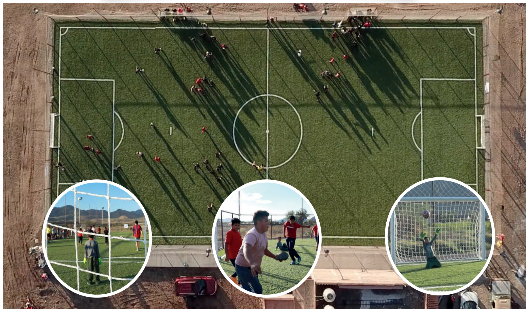
Construcción de cancha de futbol 7 Colonia Doctores.
