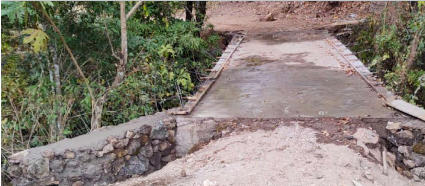
Reconstrucción puente en "Tranquillas"
