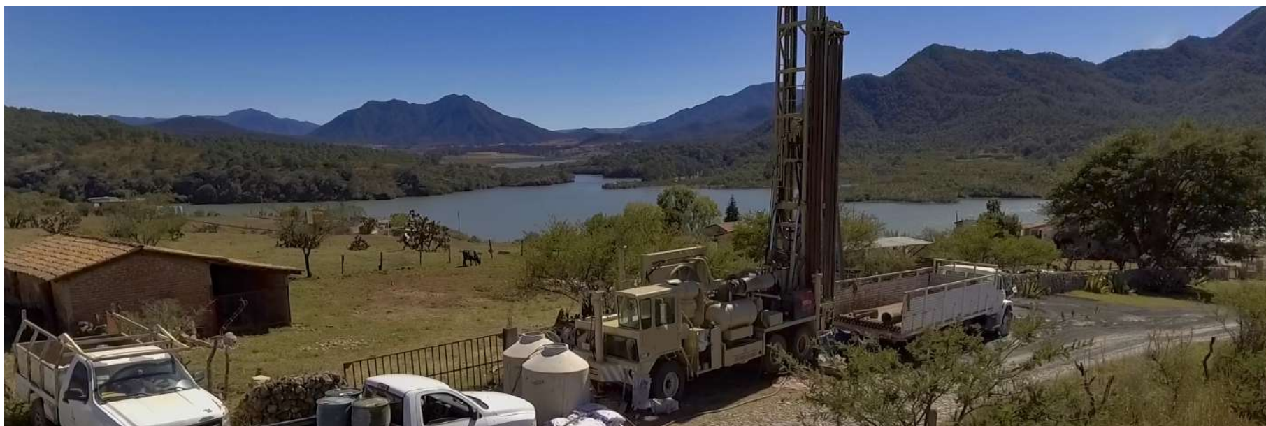
Construcción de la primera etapa de pozo profundo en La Providencia
