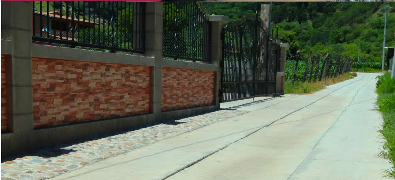
Construcción de calzada en "Cimarrón Chico"
